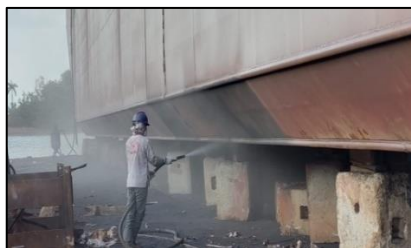
Gambar 1. Pekerjaan Sandblasting pada Bottom
